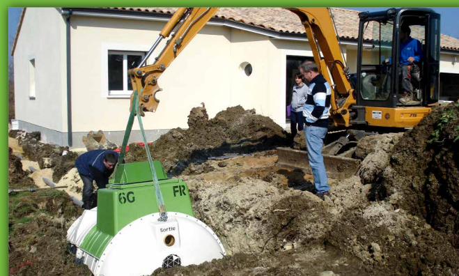
Installation d'une Tricel Novo FR6
